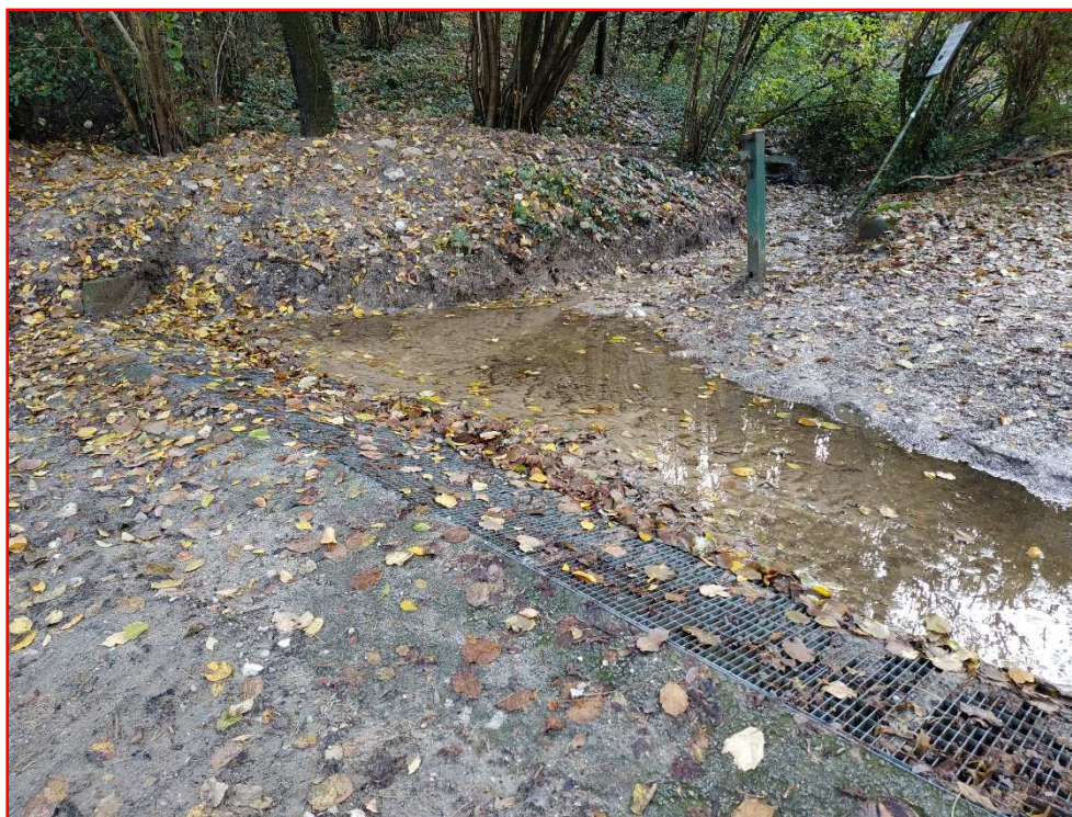
Figura 9. Particolare della griglia di captazione delle portate della roggia e dei contributi derivanti dal dilavamento superficiale del sentiero.
