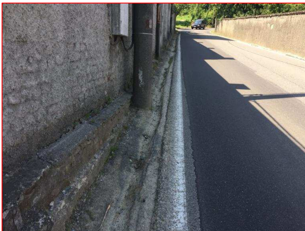
Figura 14. Particolare della cunetta stradale in destra idraulica.
