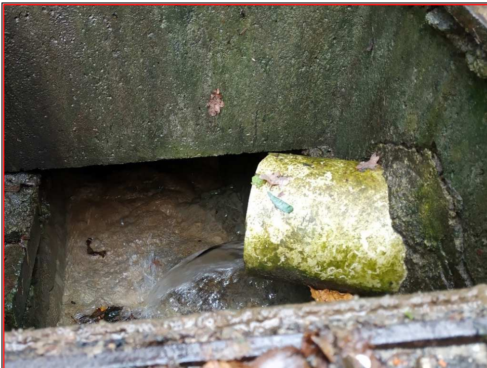
Figura 12. Particolare, nel pozzetto caditoia di via Garibaldi, della condotta di recapito delle acque dalla griglia di captazione alla rete di collettamento.
